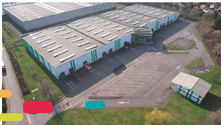
Entrepôt logistique, 16.000 m 2 , port de Santes
